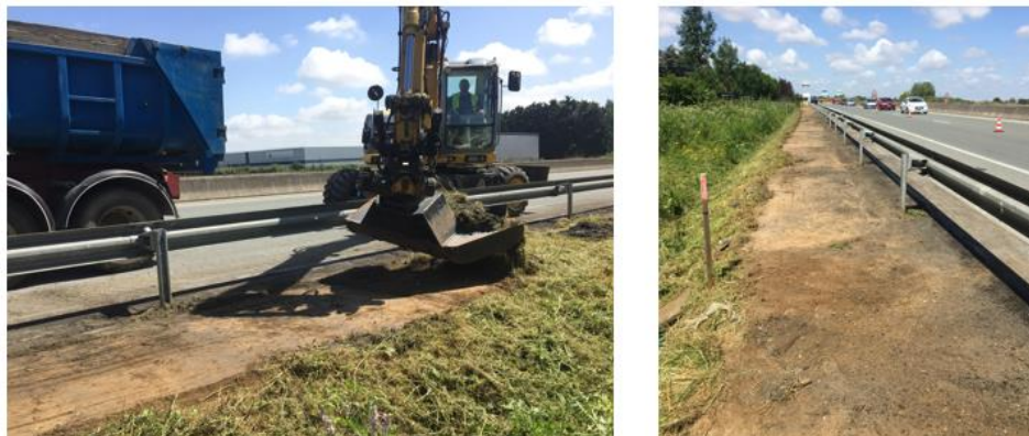
Figure 29 : photos du dérasement des bandes enherbées de Compans
